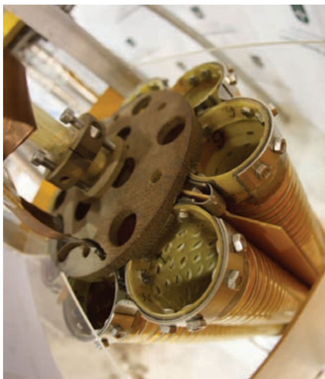
Сверхпроводниковый ограничитель токов короткого замыкания (COT) — одно из наиболее важных и безальтернативных применений ВТСП в электроэнергетике
